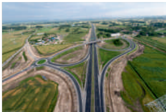
Budowa drogi ekspresowej S7 na odcinku Gdańsk (A1) – Koszwały (południowa obwodnica Gdańska)
